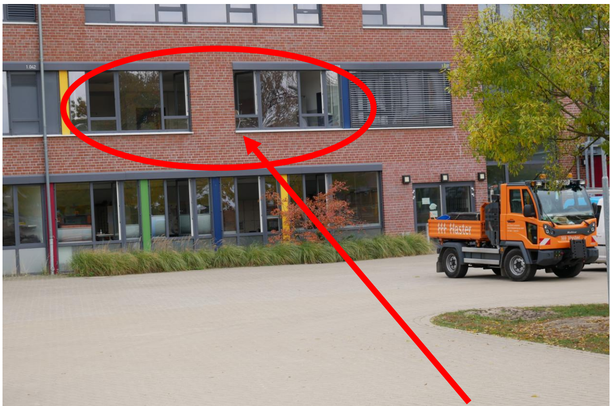
Fenster zur Lüftung extra mit Stuhl verkeilt, damit das Fenster nicht zufällt (vgl. Montag 19.10. – 11:03 Uhr)
