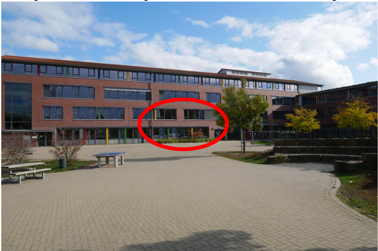
Freitag 16.10. – 13:56 Uhr Auf der gesamten Front sind die Fenster nur in 2 Räumen geöffnet.
