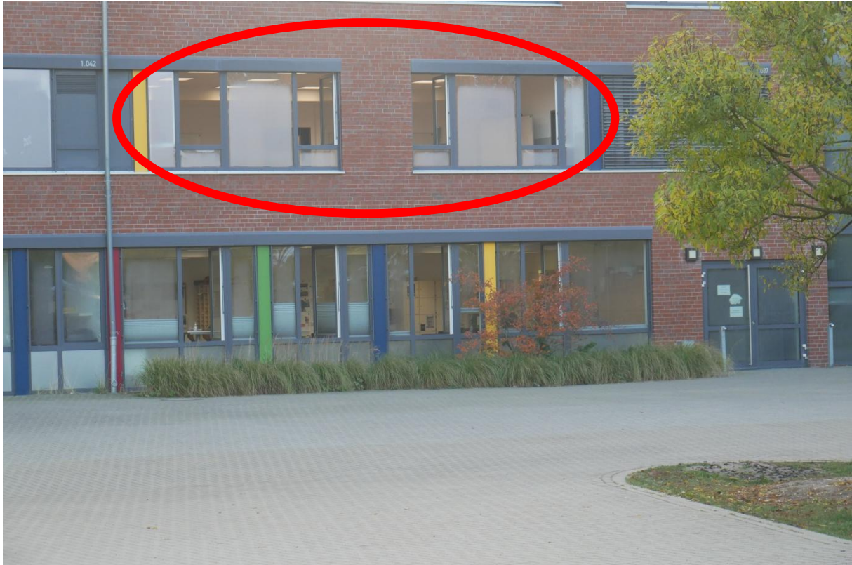
Montag, 19.10. – 8:36 Uhr Fenster vollständig geöffnet, die beschlagenen Fenster zeigen, dass es kalt ist
