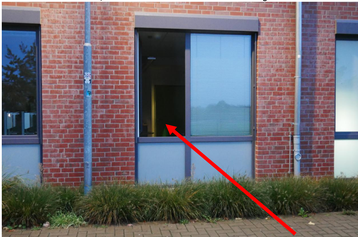
Tür ebenfalls zur Lüftung offen
